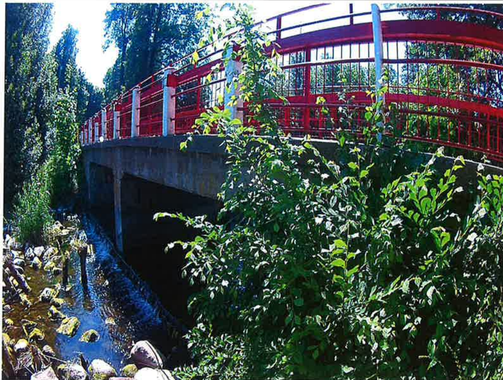
Fot. 3. Widok boczny na obiekt
