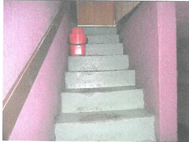
Widok na schody prowadzące do piwnicy. Ściany pokryte tynkiem typu baranek, pokryte farbą olejną.
