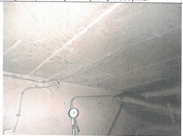
Widok na strop żelbetowy w piwnicy. Fragmenty instalacji.
