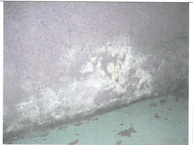
Widok miejsca występowania wykwitów solnych i pleśni na ścianach piwnicy
