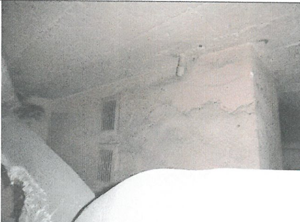
Widoczny fragment komina dymowego i wentylacyjnego.
