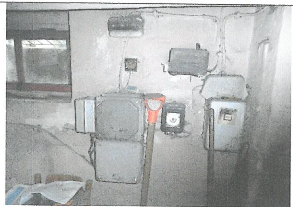
Fragmenty instalacji elektrycznej w budynku.
