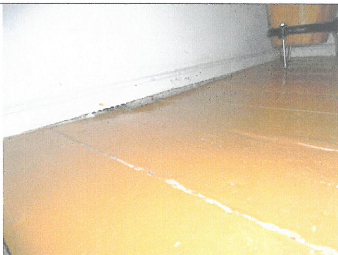
Przykład zapadającej się podłogi.
