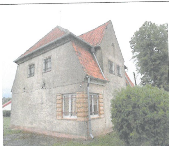
Widok na budynek od strony północno – zachodniej.
