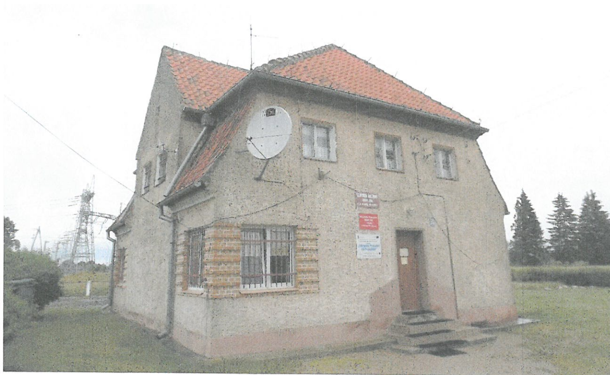
Fot. 1 Widok budynku od strony południowej od strony wejścia do biblioteki.
