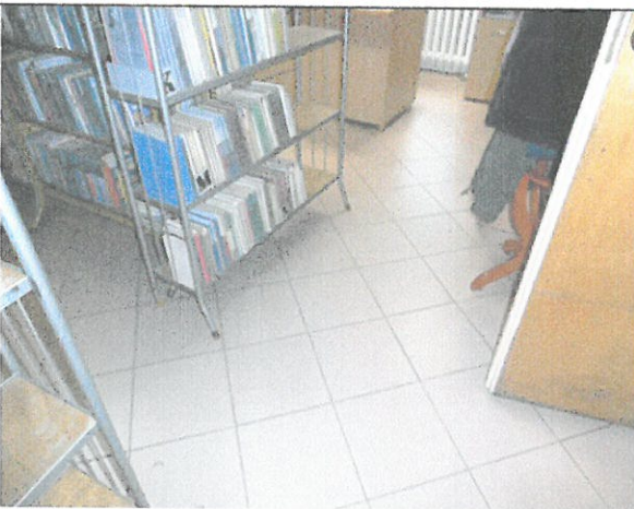
Podłoga wypożyczalni obłożona płytkami typu gres.
