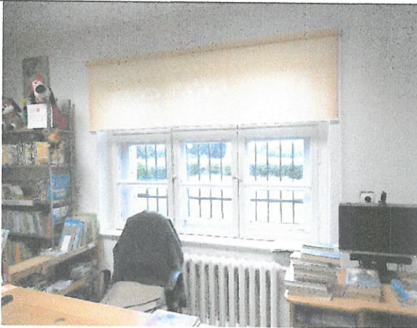
Widoczne drewniane okno skrzynkowe. Od strony zewnętrznej założona krata metalowa.
