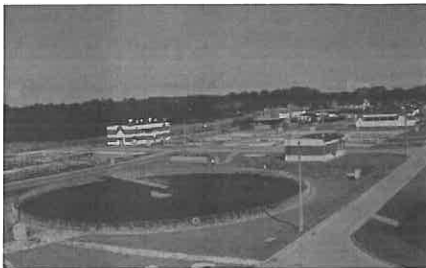
Rys. 9 Widok Oczyszczalni ścieków w Nowej Wsi Ełckiej
