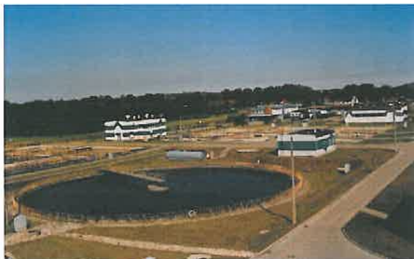
Rys. 9 Widok Oczyszczalni ścieków w Nowej Wsi Ełckiej
