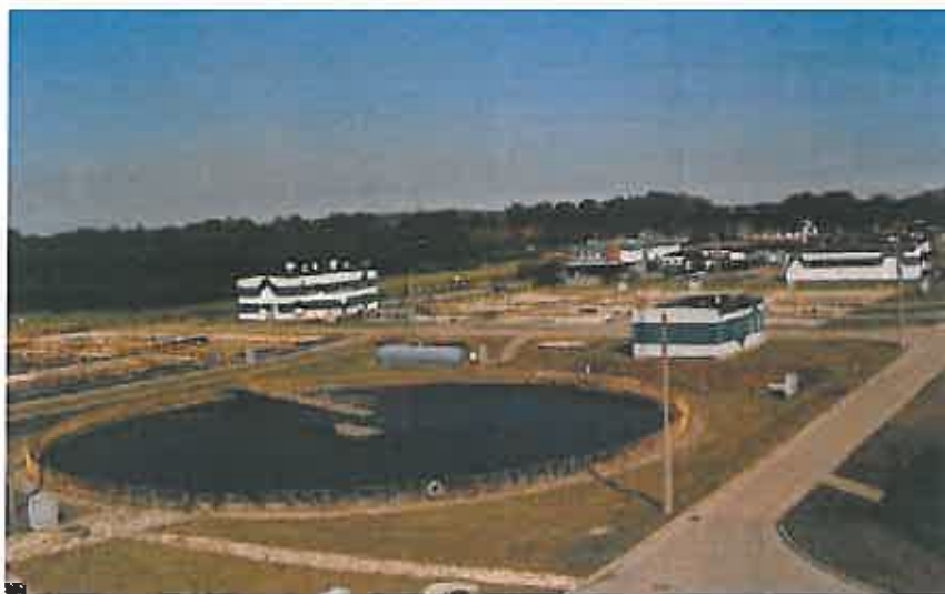
Rys. 9 Widok Oczyszczalni ścieków w Nowej Wsi Ełckiej
