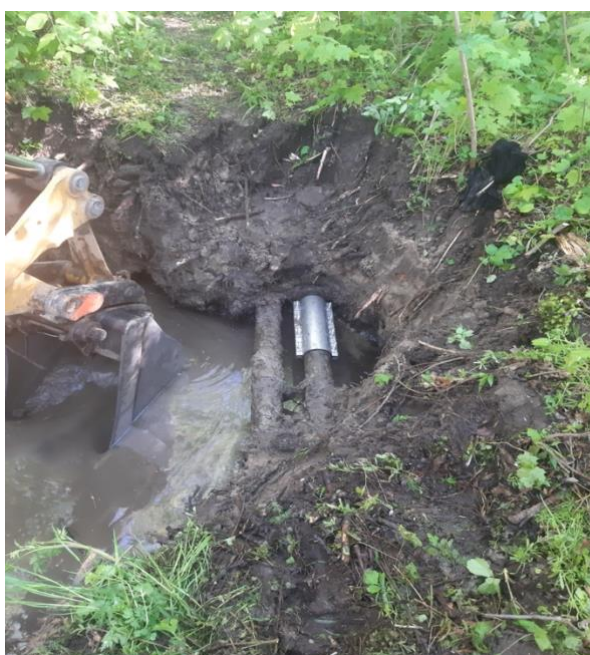
c) Awaria na sieci wodociągowej w miejscowości Straduny na głównym rurociągu zasilającym miejscowości Straduny-Piaski-Malinówka. Uszkodzona rura żeliwna o średnicy dn150 mm została wymieniona.
