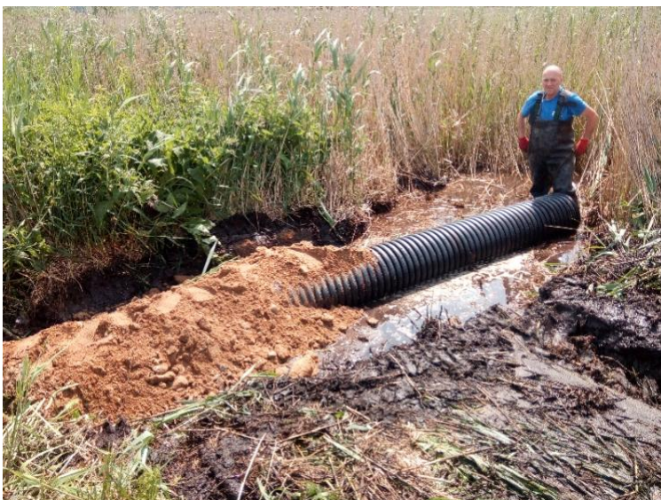
W miejscowości Straduny naprawa przepustu.
