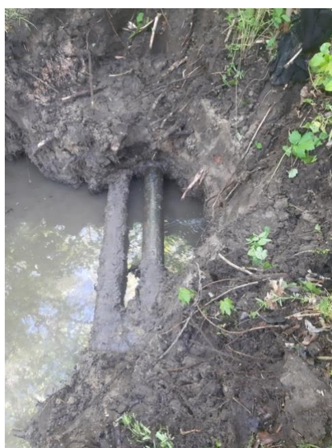
c) Awaria na sieci wodociągowej w miejscowości Straduny na głównym rurociągu zasilającym miejscowości Straduny-Piaski-Malinówka. Uszkodzona rura żeliwna o średnicy dn150 mm została wymieniona.
