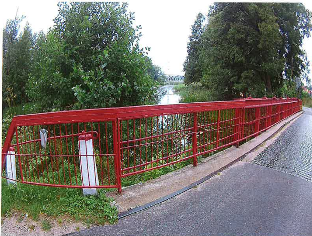
Fot. 2. Widok na barierę dla pieszych
