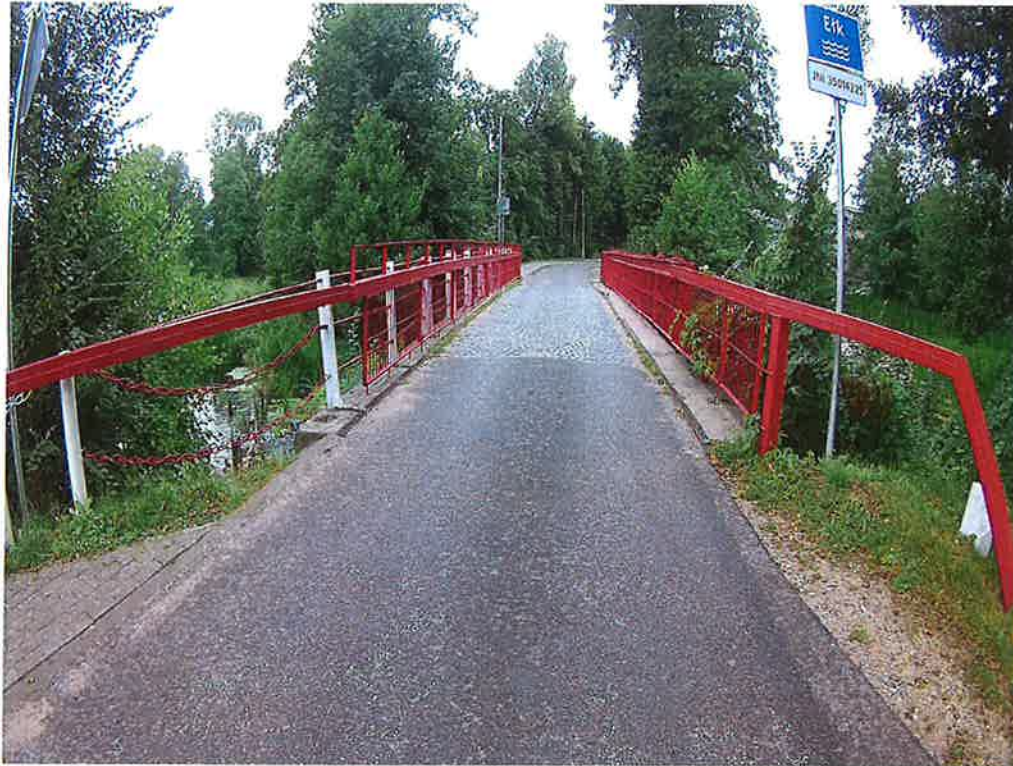
Fot. 1. Widok ogólny na most i na nawierzchnię jezdni
