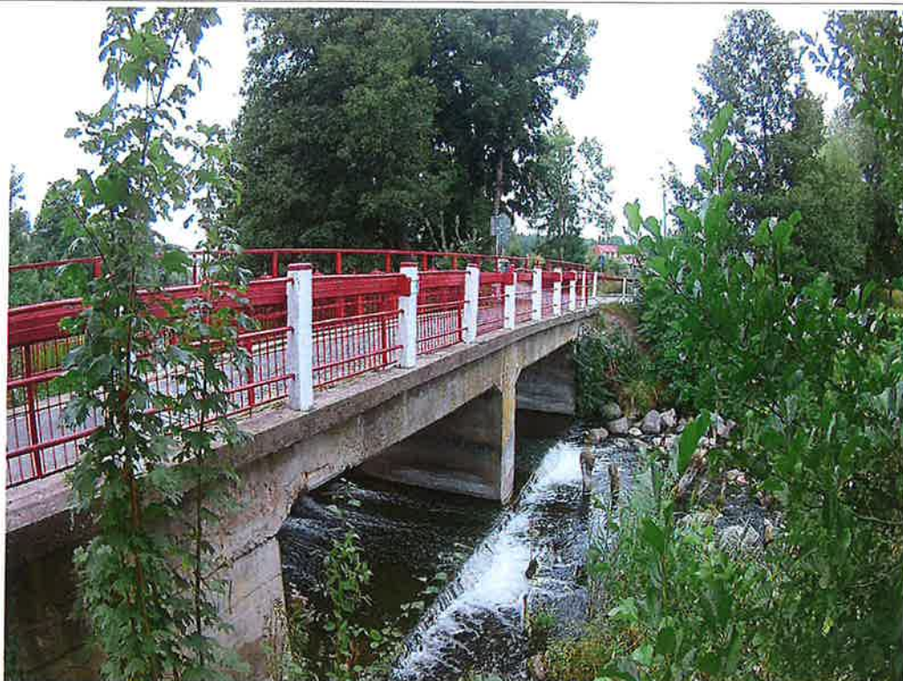
Fot. 3. Widok boczny na obiekt
