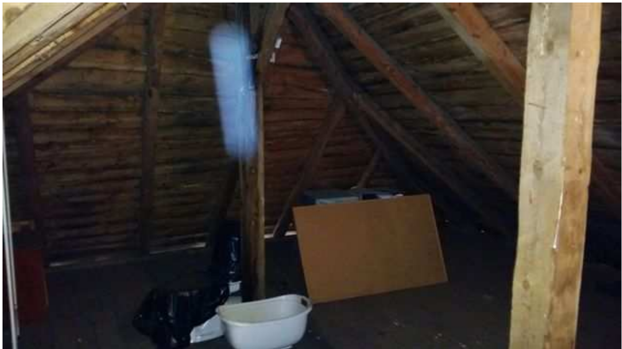
Widok konstrukcji dachu na strychu budynku
