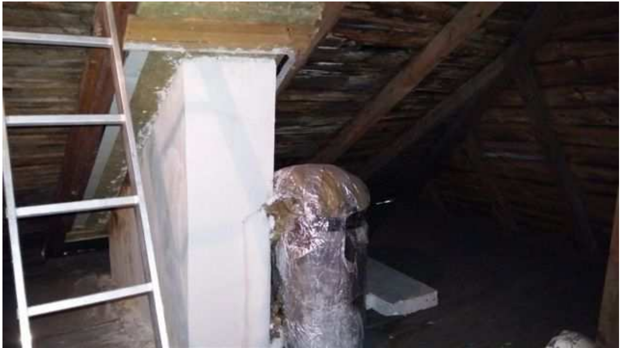
Widok komina na strychu budynku
