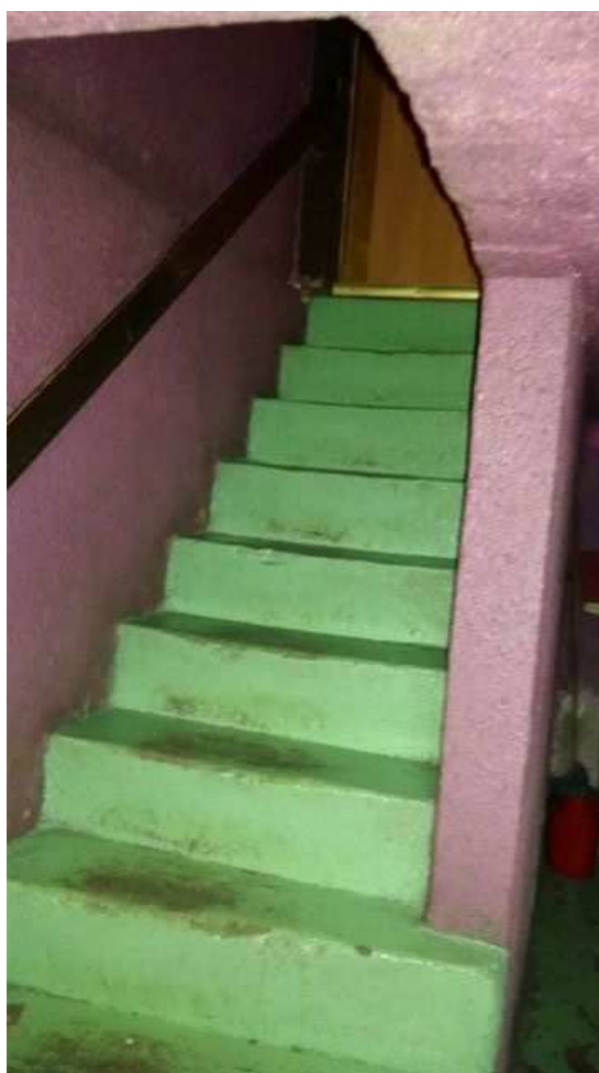
Widok schodów do piwnicy
