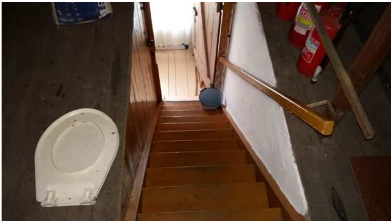
Widok schodów na strychu
