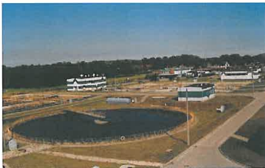
Rys. 9 Widok Oczyszczalni ścieków w Nowej Wsi Ełckiej
