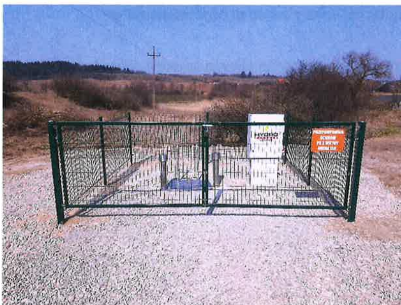
Nowa przepompownia Wityny.
