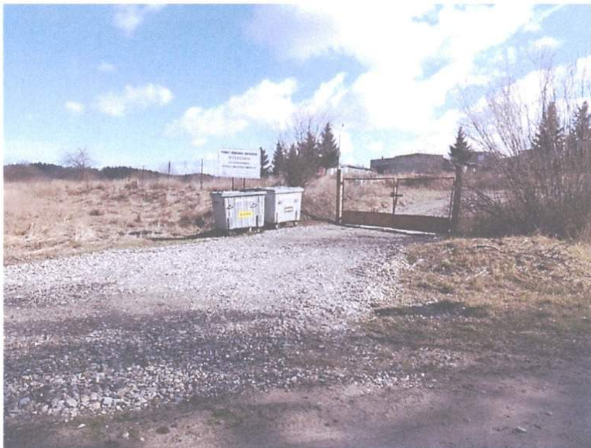
Dojazd do przepompowni w m. Rożyńsk.
