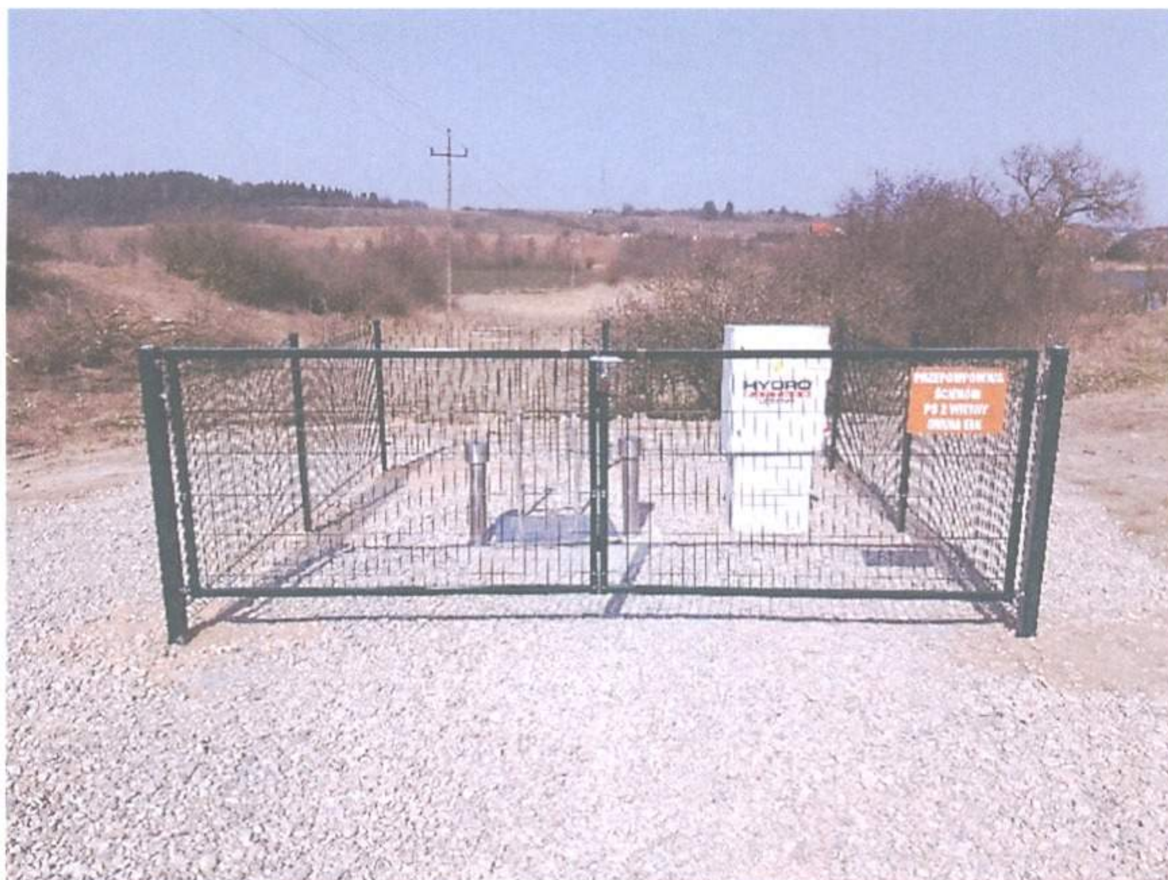
Nowa przepompownia Wityny.
