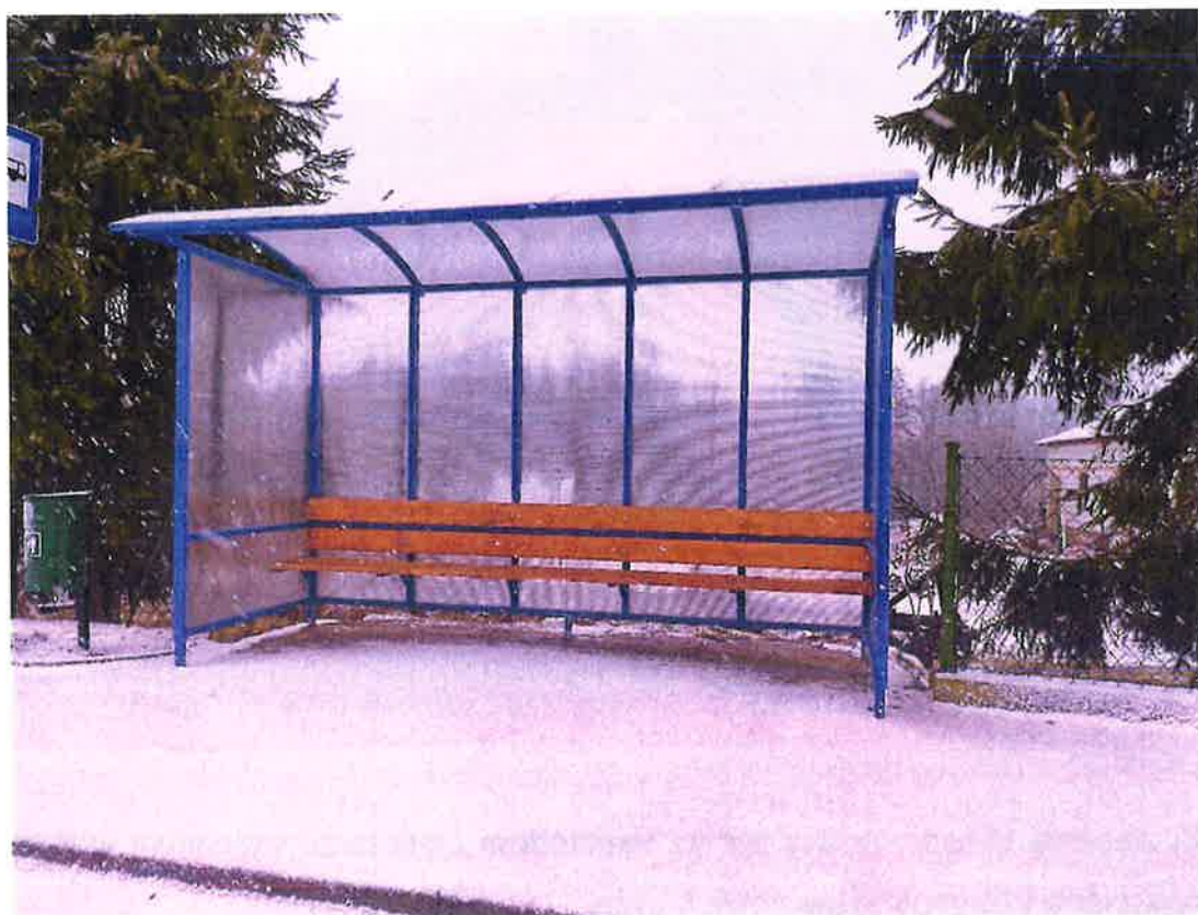
Wiata przystankowa w Mołdziach przy budynku nr 46
