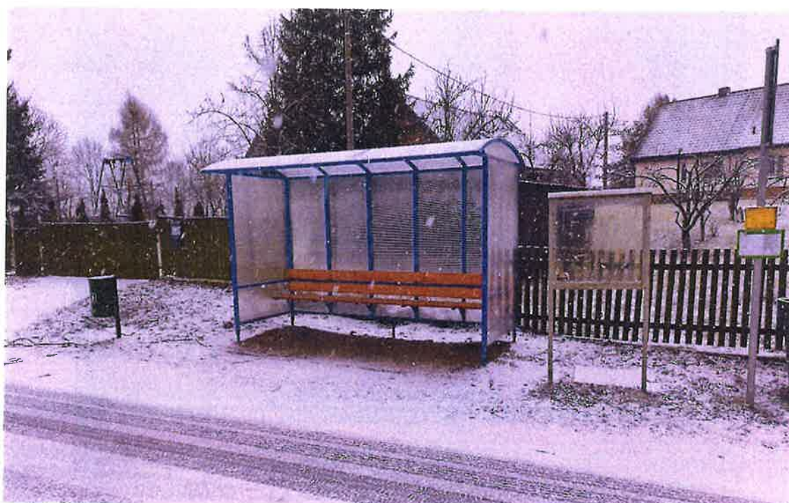
Wiata przystankowa w Bartoszech przy budynku nr 1
