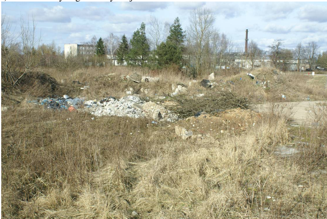
Fot.7. Wysypisko gruzu i odpadów na dz. nr ewid. 12
