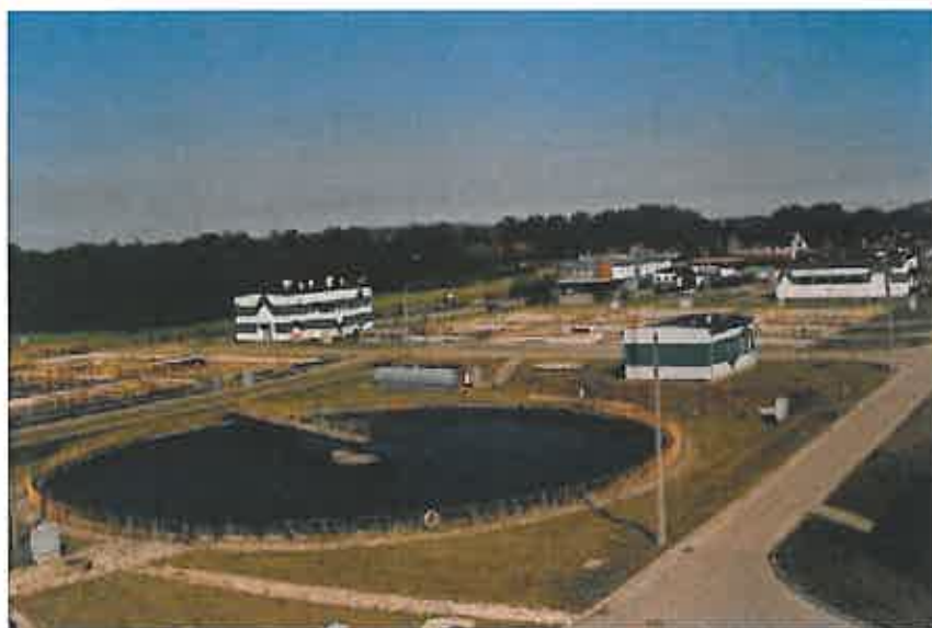
Widok Oczyszczalni ścieków w Nowej Wsi Etckiej
