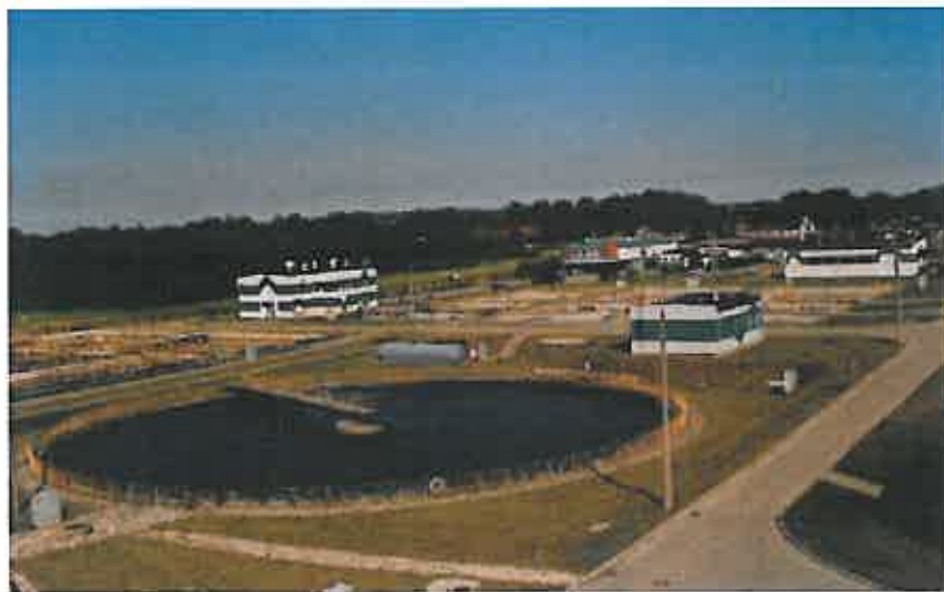
Rys. 9 Widok Oczyszczalni ścieków w Nowej Wsi Ełckiej
