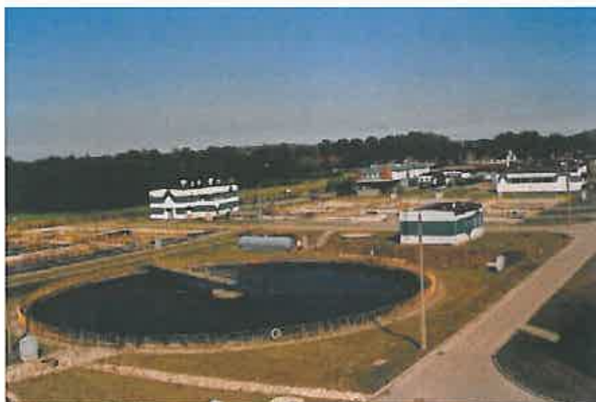
Widok Oczyszczalni ścieków w Nowej Wsi Elkiej
