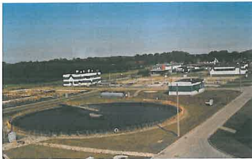
Rys. 9 Widok Oczyszczalni ścieków w Nowej Wsi Ełckiej
